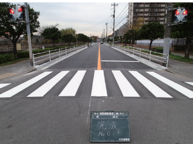
道路舗装補修工事(その1)
