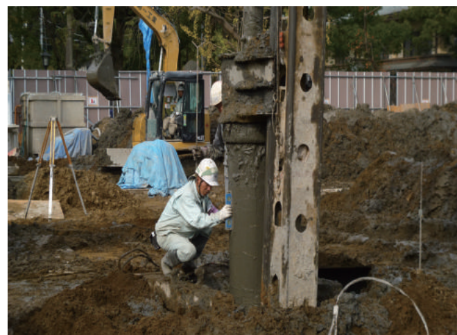
市川市市民会館建替杭工事
