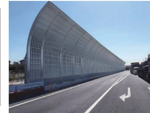
田尻高谷遮音壁その1工事(工建設(株))
