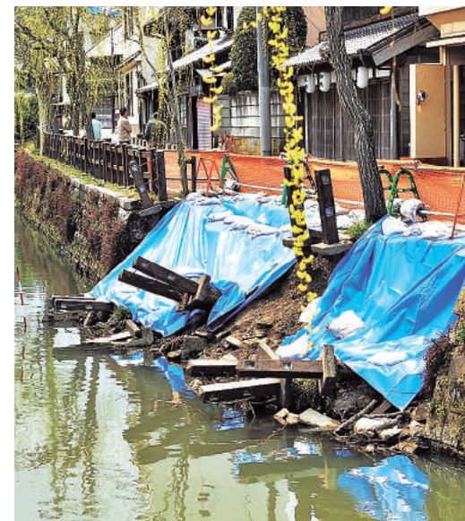
香取市内の被災状況 (千葉県提供)
