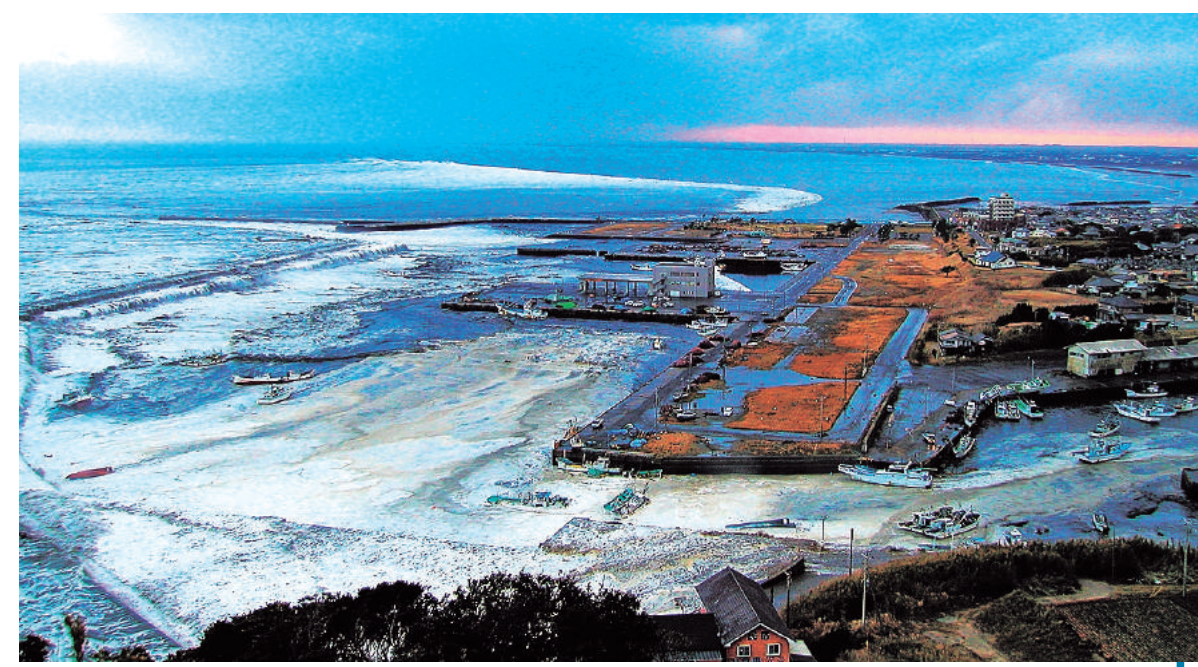
2011年3月11日の午後5時13分頃、飯岡漁港を襲う津波。さらにこの後、飯岡の街へと津波が向かう(写真提供/旭市)
