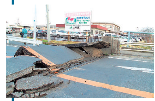
香取市役所前の港橋(県道水戸鉾田佐原線)。液状化による側方流動で道路が押し上げられて、舗装が盛り上がった(写真提供/香取市)
