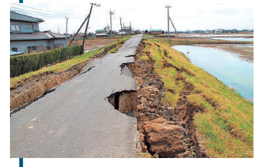
利根川以北の農村地域(北佐原地区)での道路崩壊(写真提供/香取市)
