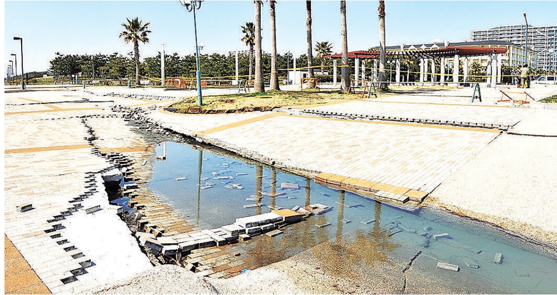
浦安市内の被災状況 (千葉県提供)
