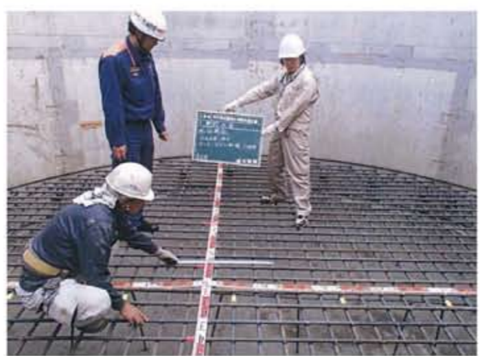
市川市立国分小学校外構工事
