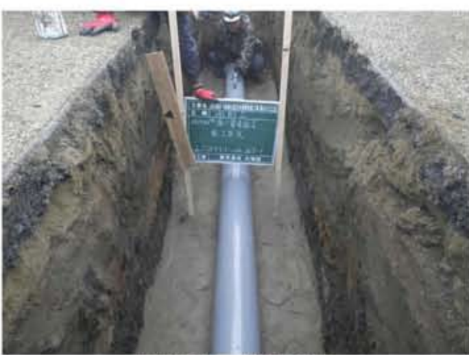
市川第2-1処理分区分区汚水管渠布設工事(第2612工区)
