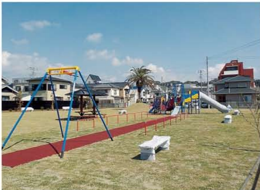
(潮風公園施設整備工事) 工建設(株)勝浦営業所施工・(仮称) 潮風公園施設整備工事
