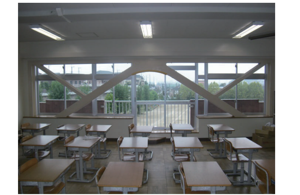
松戸市立河原塚小学校西校舎耐震及びトイレ改修工事
