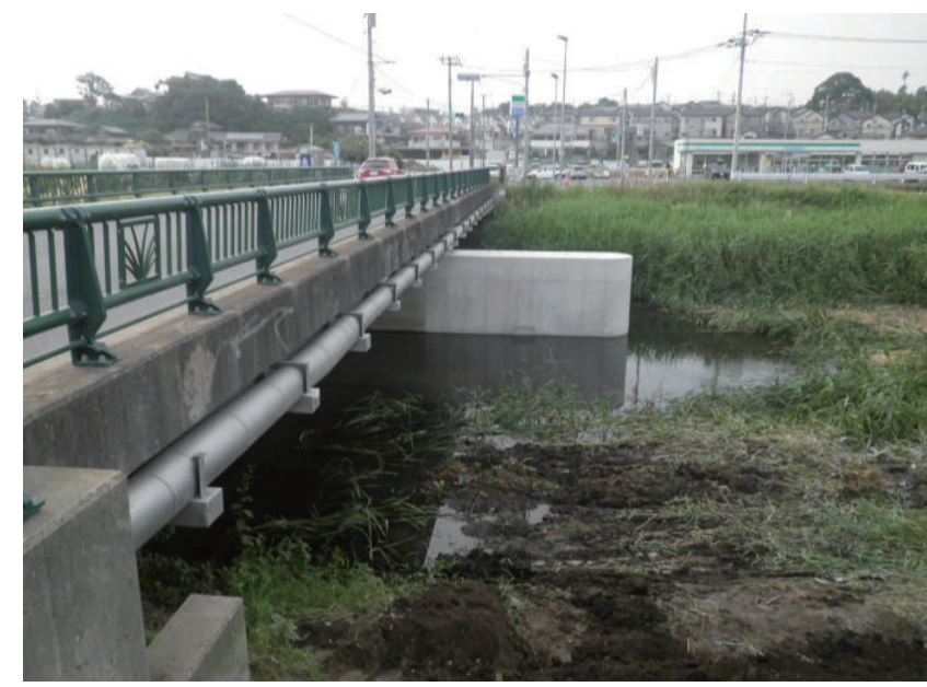
大山橋下部工事その1
