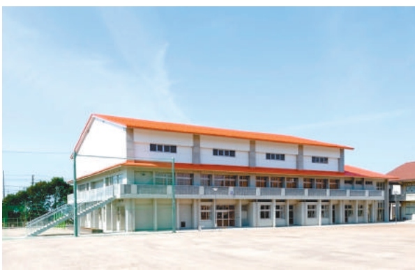
房南地区小中一貫校施設整備工事 (白幡興業)
