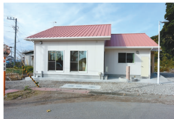
那古学童クラブ建設工事 (渡辺建設)
