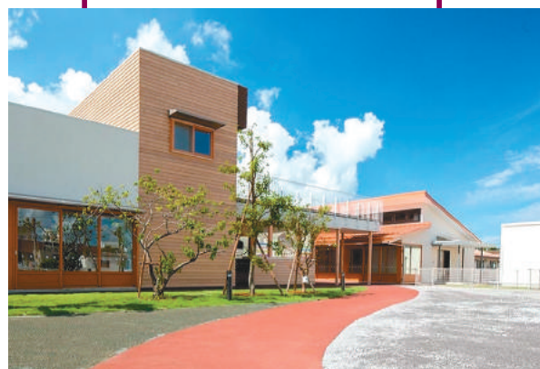
北条幼稚園建設工事 (渡辺建設)
