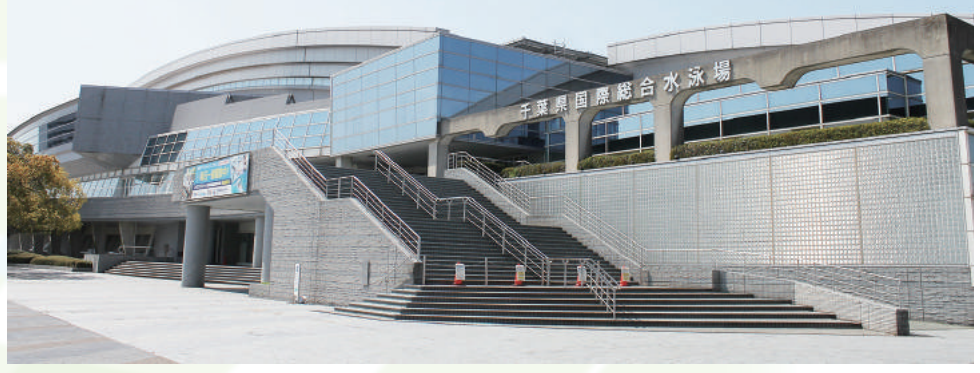
県国際総合水泳場
