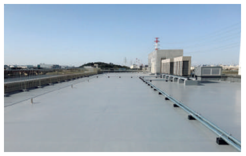
市川市クリーンセンター管理棟外壁・屋上防水改修工事
