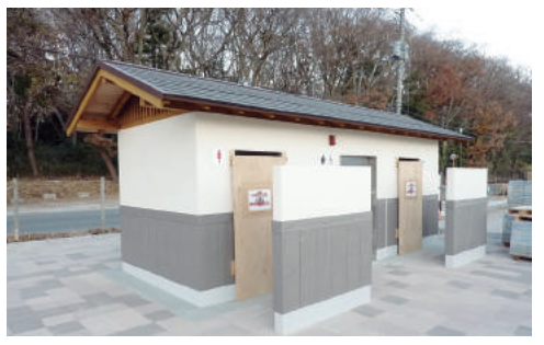
小塚山公園(便益・休養施設)整備工事
