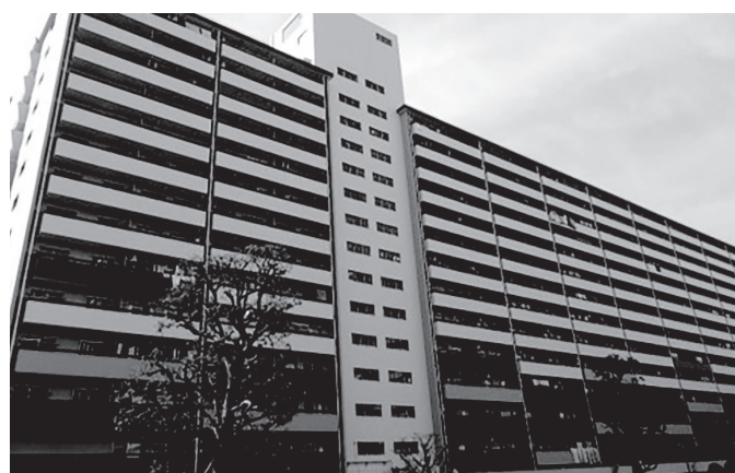
東日本賃貸住宅本部 (保全建築) R01高島平団地2-33-2号棟他1棟 外壁修繕その他工事
