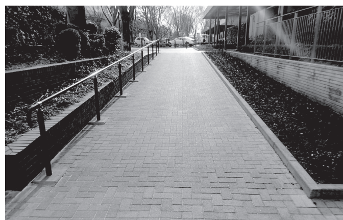
東日本賃貸住宅本部 (造園) R02所沢PT駅前通り環境整備(造園) 工事
