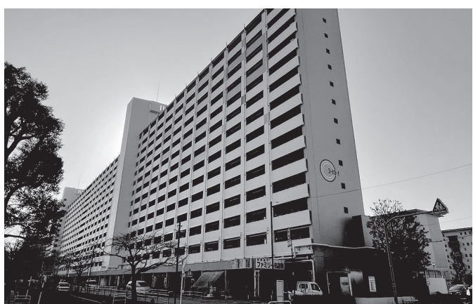
東日本賃貸住宅本部 (保全建築) R01高島平団地3-10-1号棟 外壁修繕その他工事
