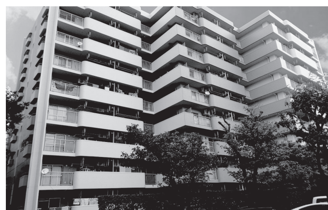
東日本賃貸住宅本部 (保全建築) R01葛西クリーンタウン清新南ハイツ 1-2号棟他1棟外壁修繕その他工事
