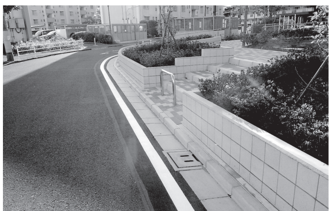
東日本賃貸住宅本部 (保全土木) H31みさと南地区環境整備(土木) その7工事
