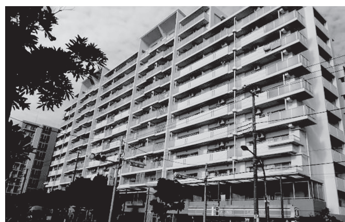
東日本賃貸住宅本部 (保全建築) R01ラ・ヴェール東陽町 外壁修繕その他工事
