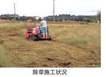
除草施工状況
