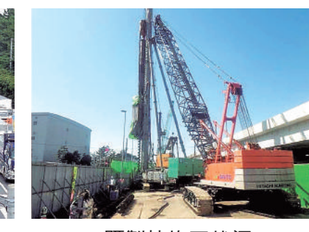
既製杭施工状況
