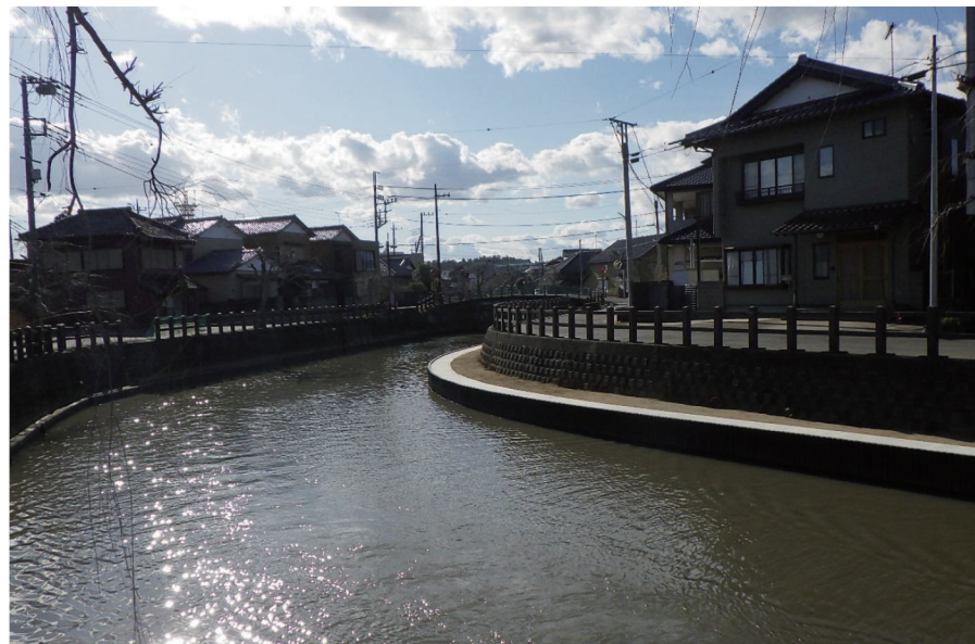
総合流域防災工事 (小野川鋼矢板護岸工その2)
