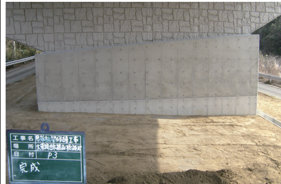
県単橋梁修繕工事 (大菅跨線橋耐震補強工)
