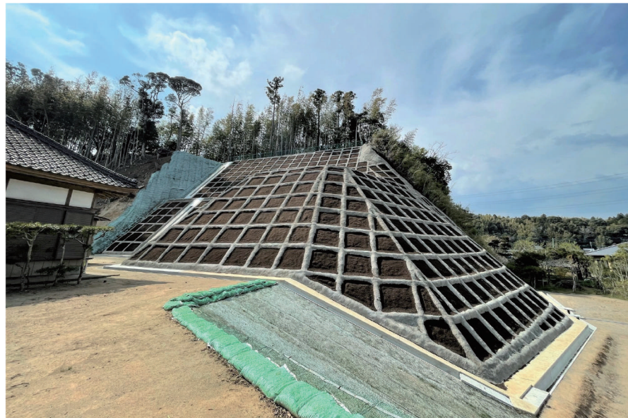
急傾斜地崩壊対策工事 (柴田2 法面保護工)
