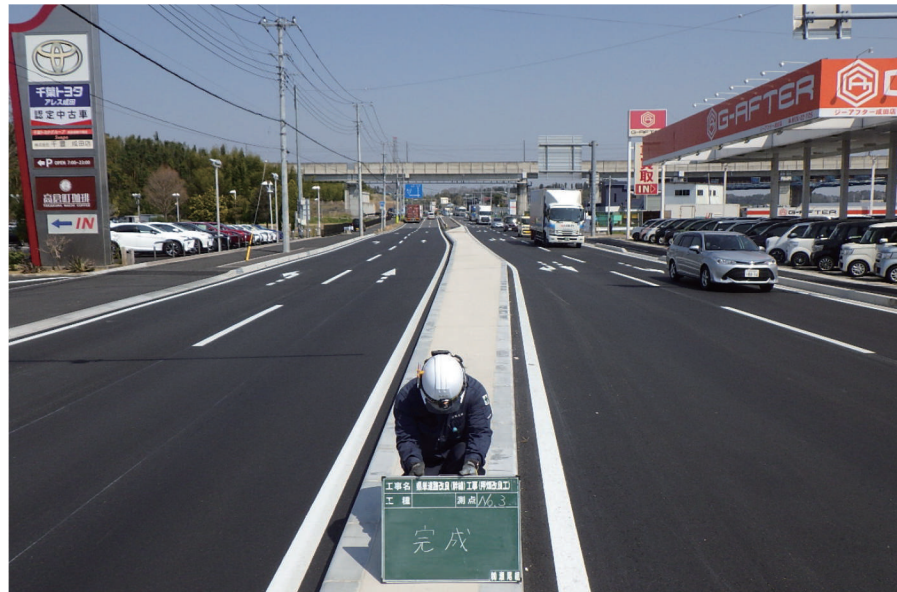
県単道路改良 (幹線) 工事 (押畑改良工)
