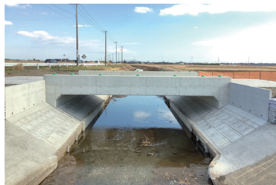
豊和 排水路横断工事
