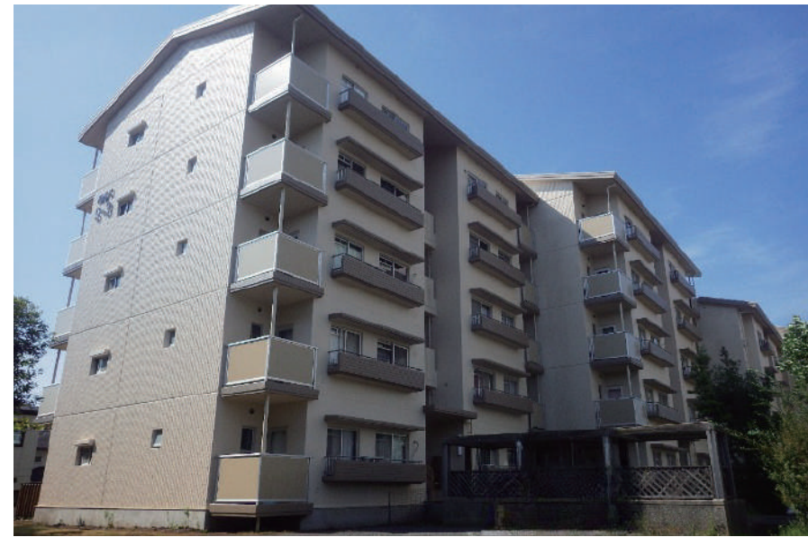
生実県営住宅S-1~3号棟 外装改修他工事 (令和2年度)
