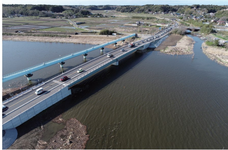
県単道路改良工事 (舟戸大橋迂回路撤去工その2) 現場代理人/監理技術者 椎塚一晴
