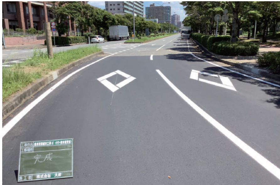
県単港湾維持工事（ポートタワー排水管更新）
