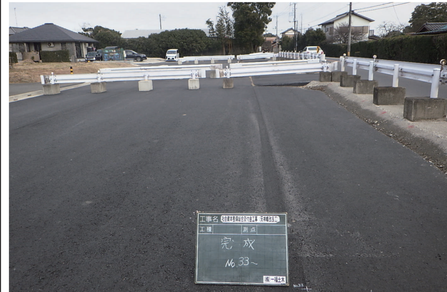
社会資本整備総合交付金工事 (天神峰改良工)
