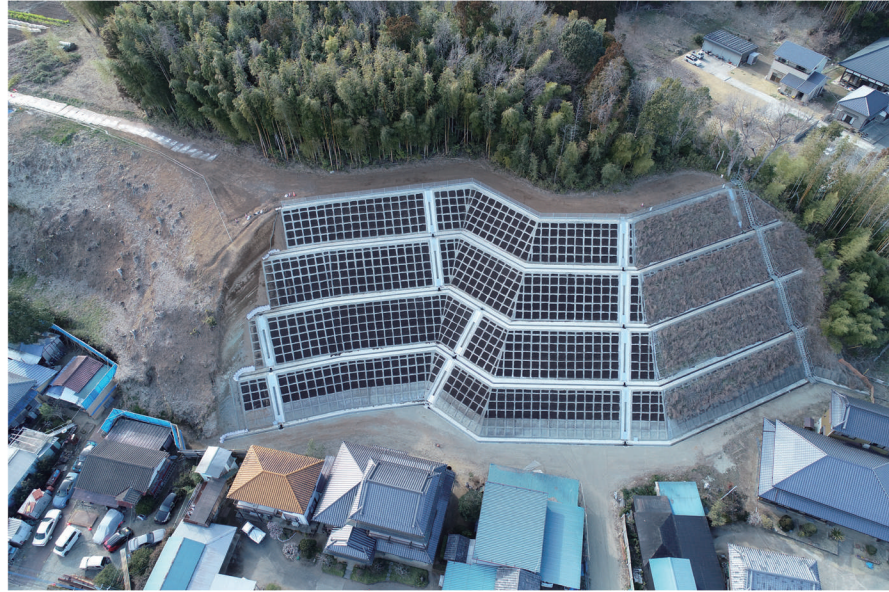
土砂災害防止 (急傾斜) 工事 (辺田その2)
