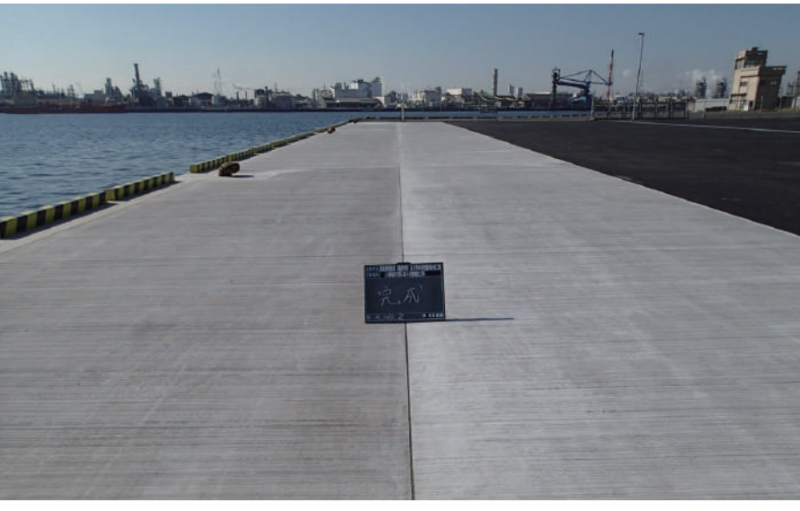
県単港湾整備（港建特別）及び県単港湾整備 合併工事（八幡地区市原ふ頭A岸壁舗装工） 現場代理人/主任技術者 鈴木敏夫
