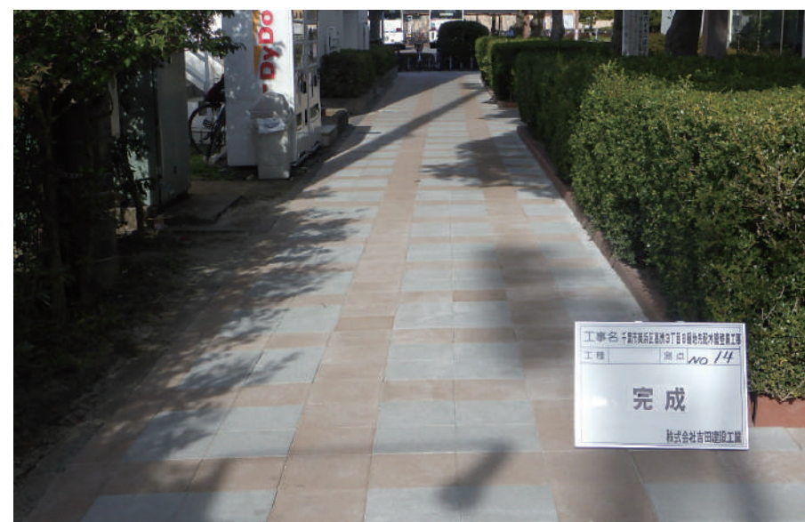
千葉市美浜区高洲3丁目8番地先配水管整備工事
