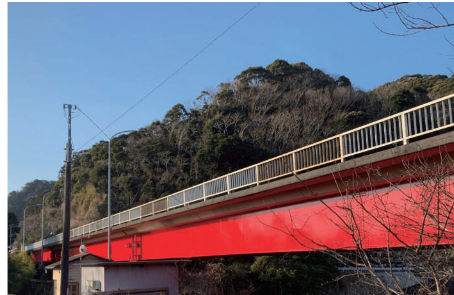
道路メンテナンス（橋梁）工事（新波太橋・補修工）
