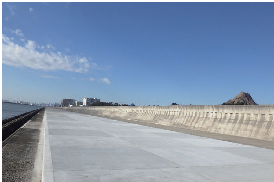
海岸基盤整備工事 (浦安海岸水叩工その1 6)
