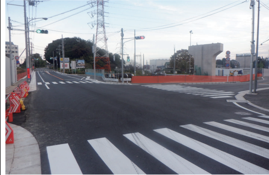
地方道道路改築工事 (和田堀切回工その1)
