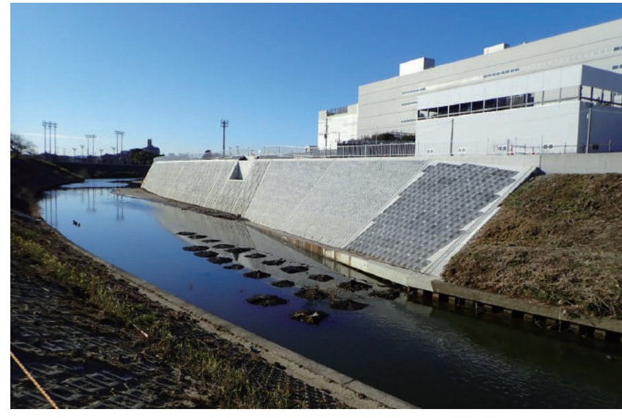
広域河川改修（連携）工事 （一宮川局部改良護岸工その3）
