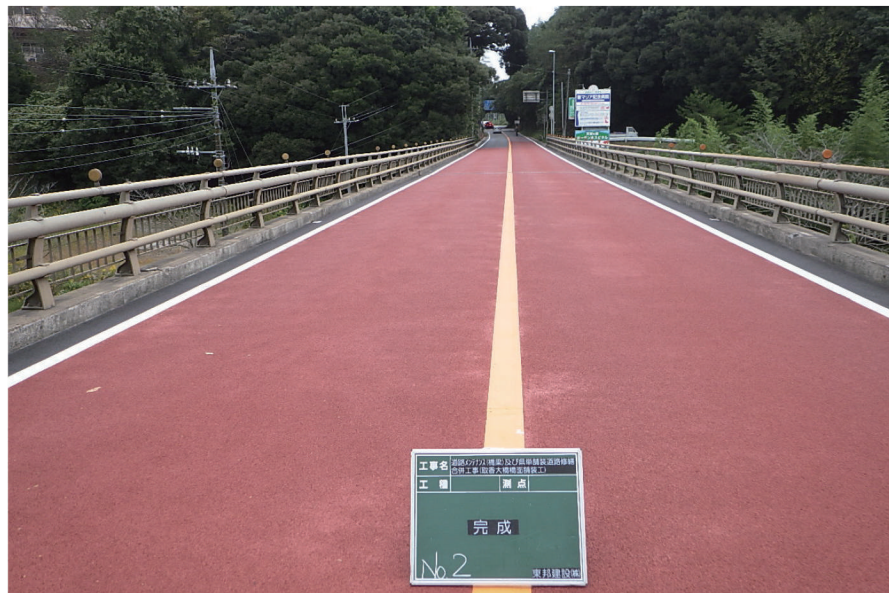
道路メンテナンス (橋梁) 及び 県単舗装道路修繕合併工事 (取香大橋橋面舗装工)
