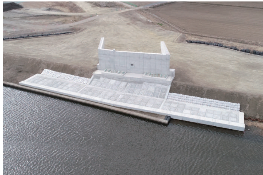
ふさのくに観光道路工事 (仮称黒部川新橋A2橋台工)
