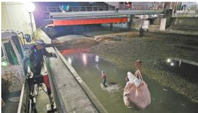
小型ユニック車により牡蠣殻を引き上げる
