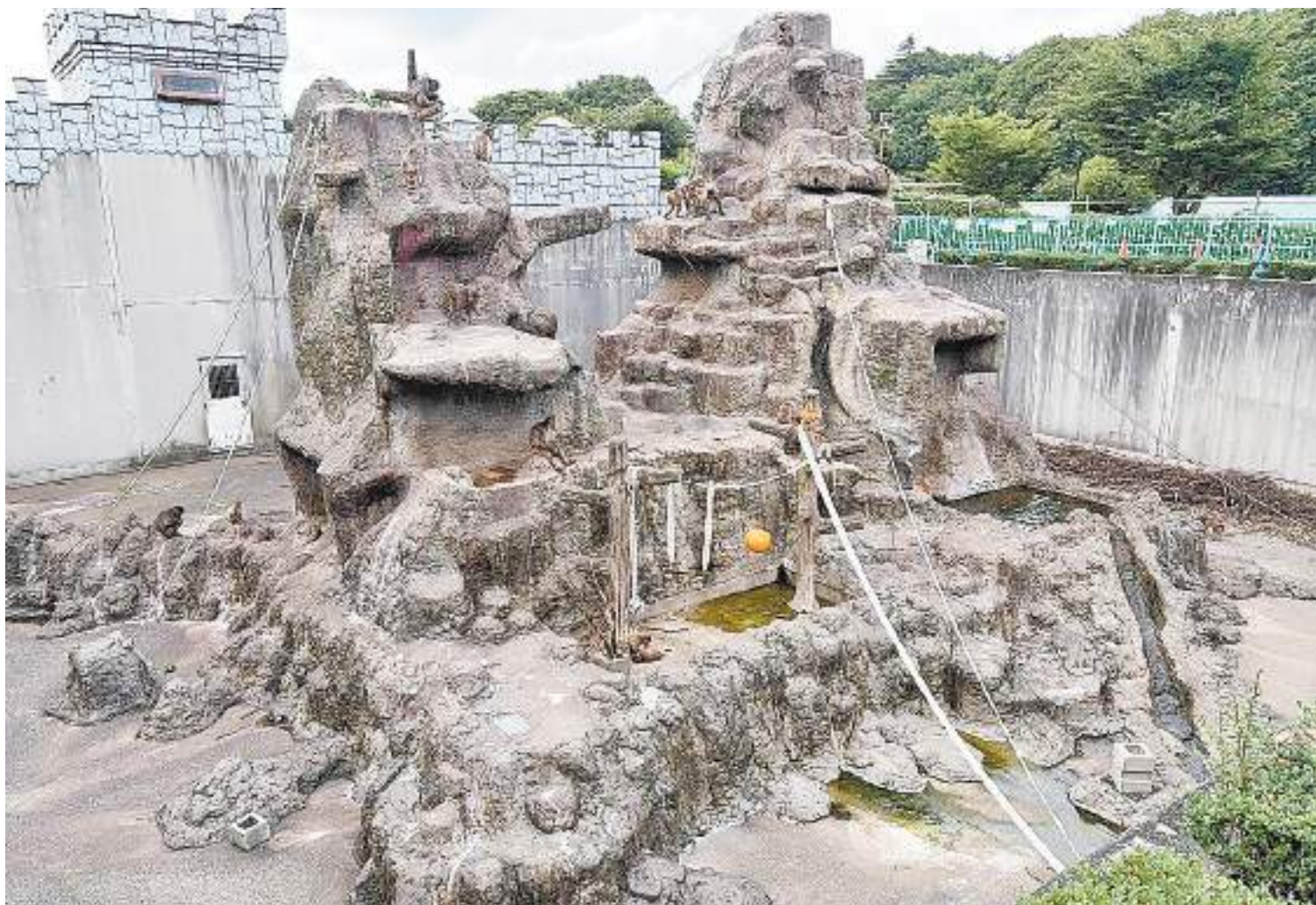
サル山の全景(写真提供:市川市動植物園)
