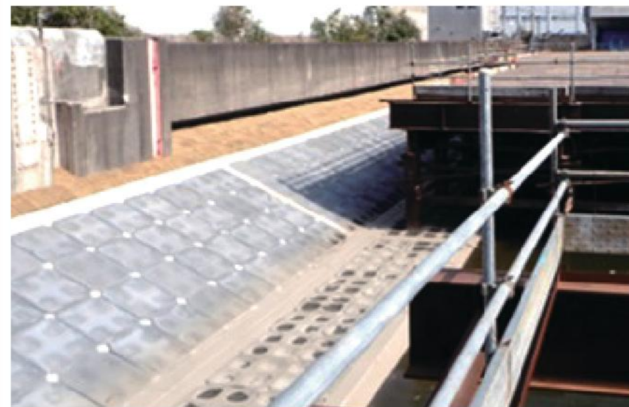
広域河川改修工事(高谷川護岸工)
