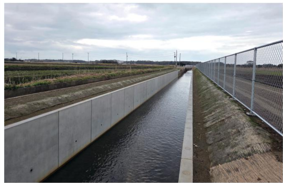
蓮沼2期(2工区) R7排水路護岸工事(その1)
