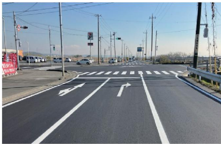
小櫃川地区道路改修(その15)工事
