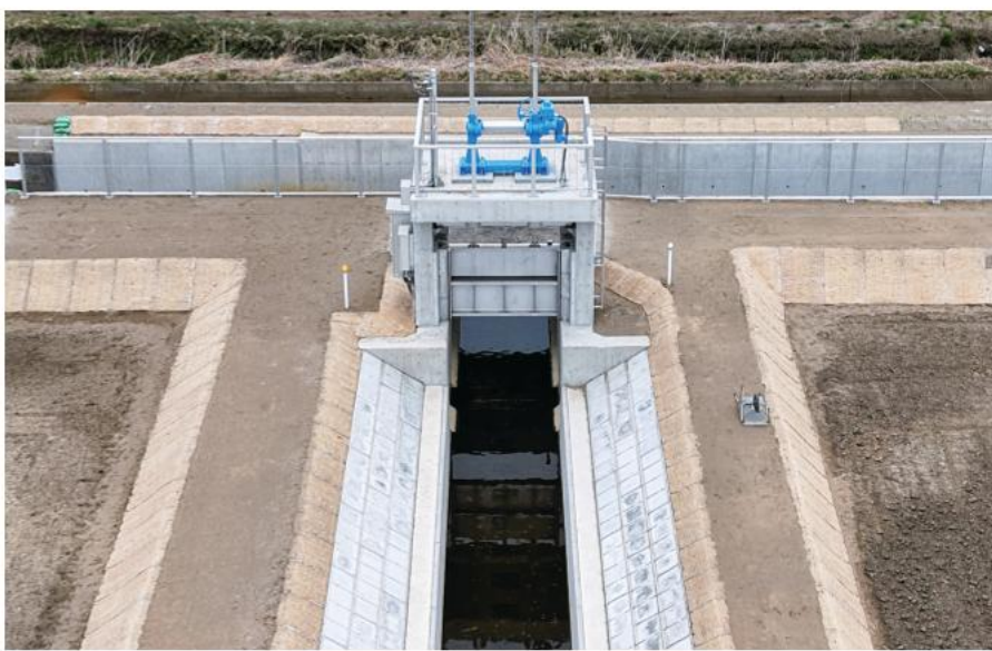
蓮沼2期(2工区) R7取水堰及び道路横断工事
