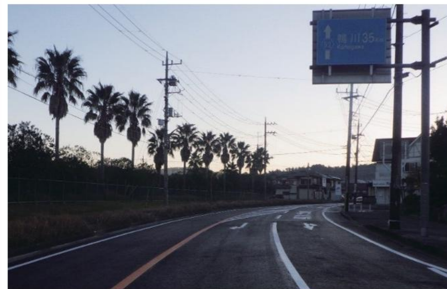
防災・安全交付金(舗装修繕)工事(内箕輪・舗装工)
