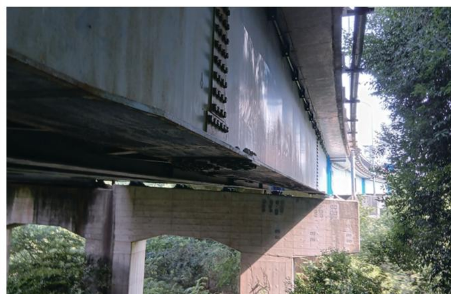
道路メンテナンス(橋梁)工事 (岩山橋下り線補修工)
