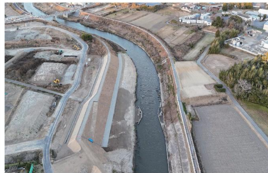
河川激甚災害対策特別緊急工事 (猿袋外・築堤工その15)
