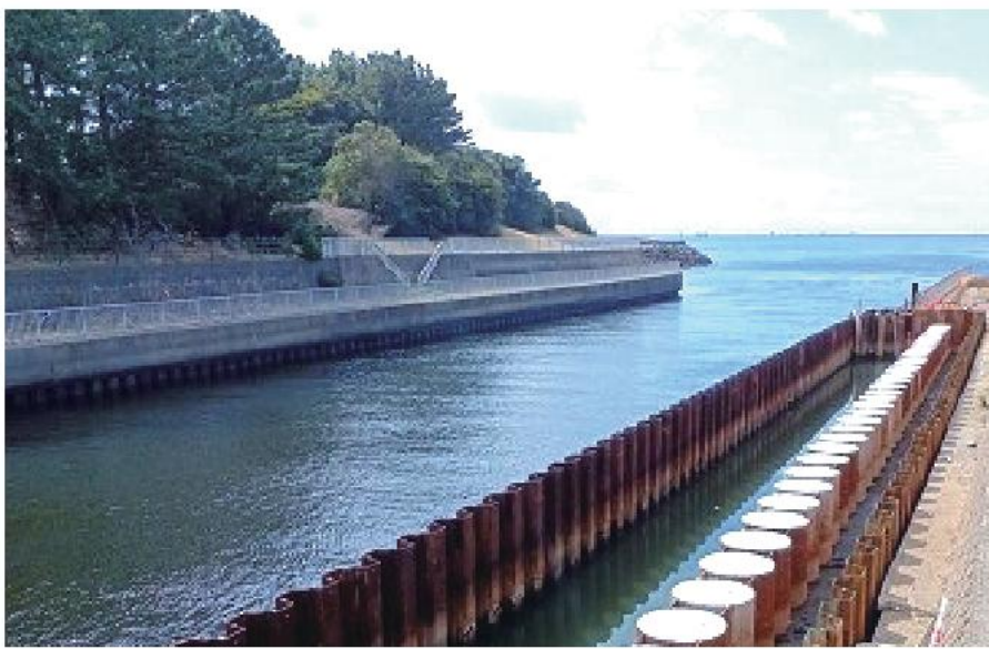
県単河川維持工事(浜田川護岸工)
