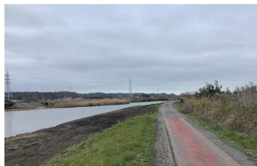
県単河川改修工事 (富下外・栗山川河道掘削工)
