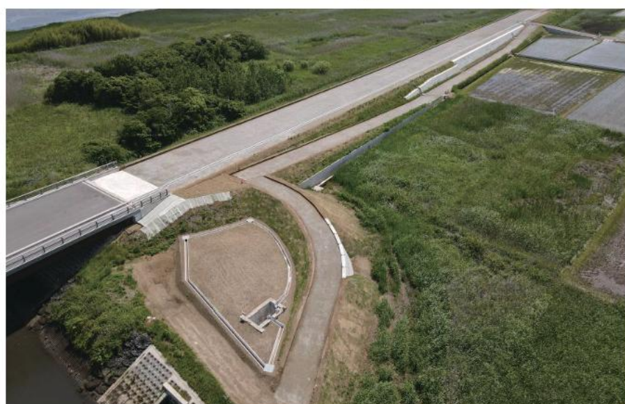
社会資本整備総合交付金工事 (銚子B P道路改良工その1)
