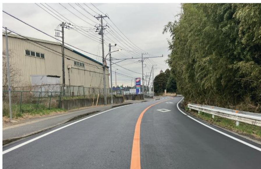
県単舗装道路修繕工事(尾上)
