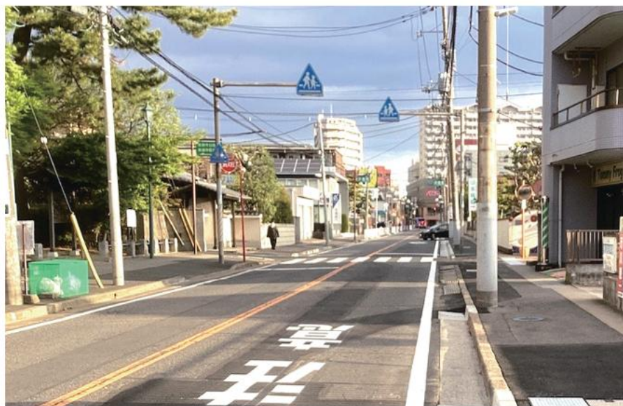
無電柱化推進計画工事(小金)
