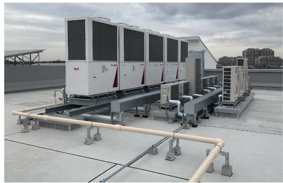
(仮称) 印旛児童相談所機械設備工事
