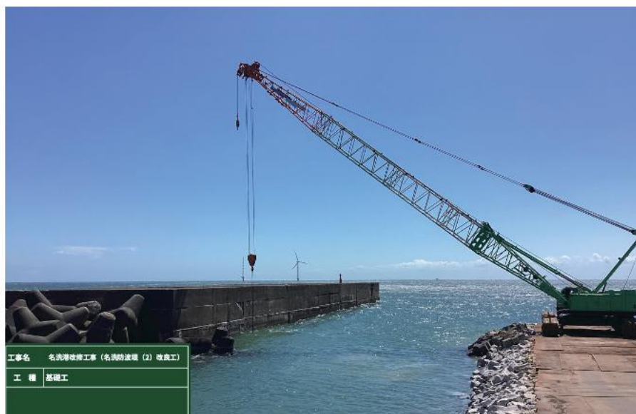
名洗港改修工事 (名洗防波堤(2)改良工)
