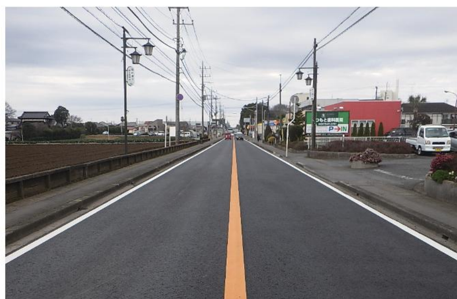
県単舗装道路修繕工事 (七栄工区その2)
