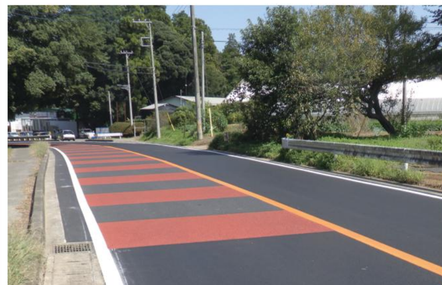
県単舗装道路修繕工事(上勝田)
