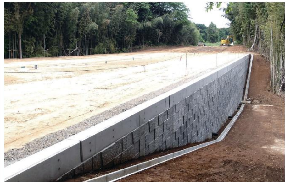
社会資本整備総合交付金工事(上高野擁壁工)
