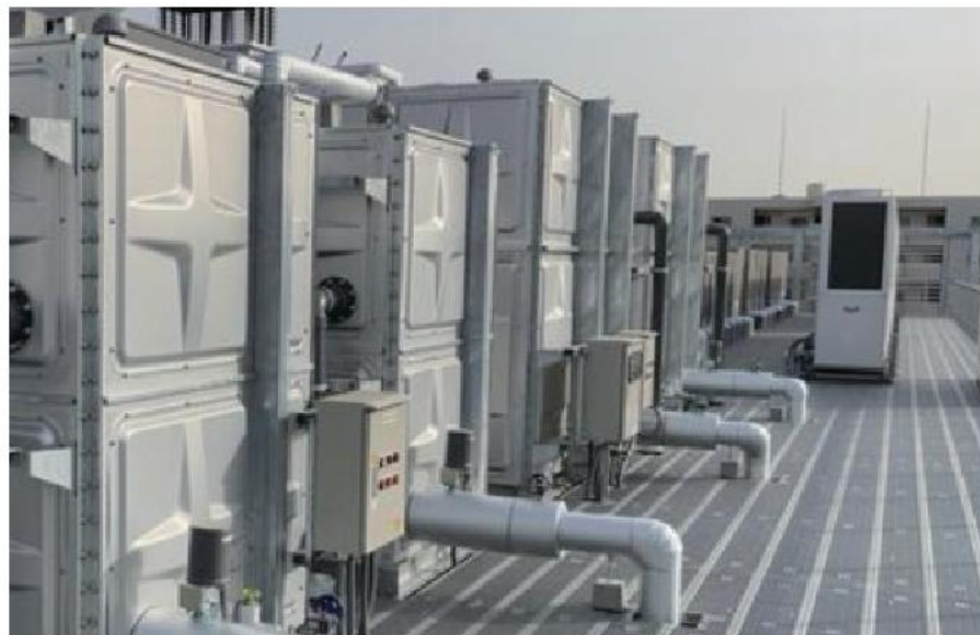
千葉県企業局本局新庁舎(仮)衛生設備工事
