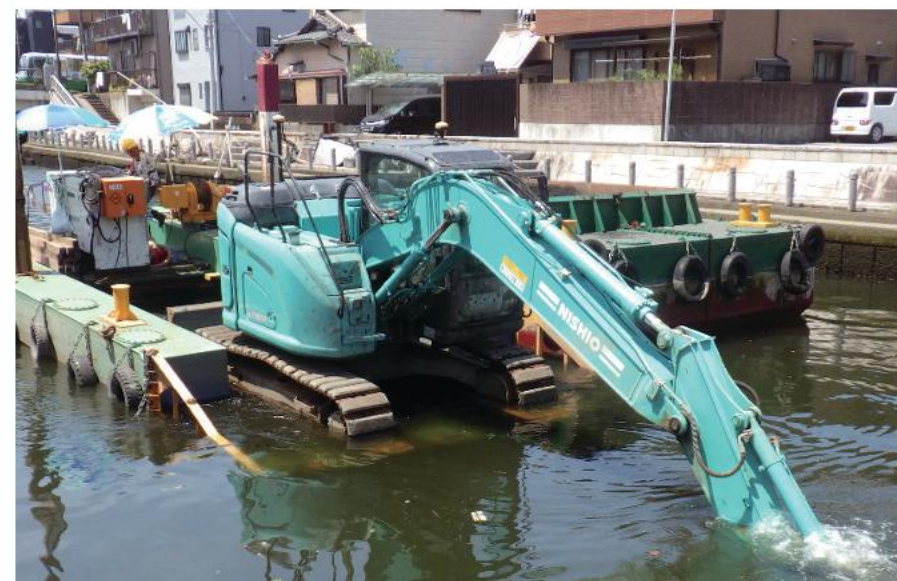
広域河川改修工事 (海老川河道掘削工その2)
