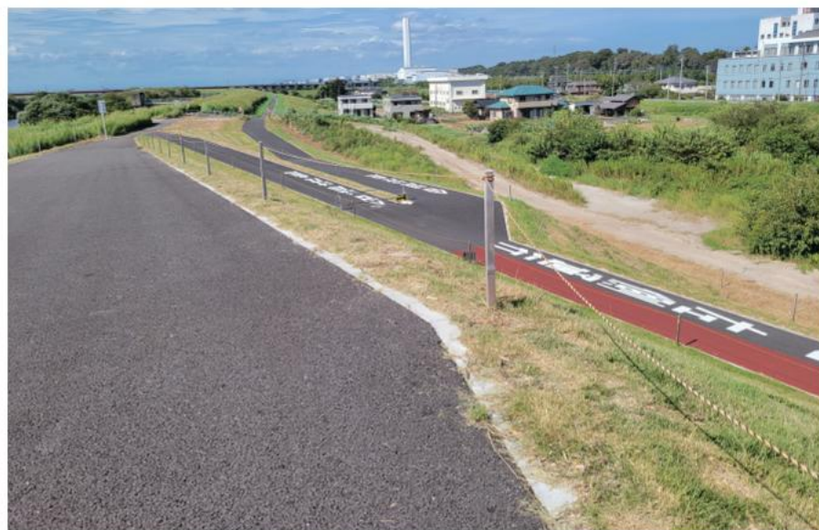
県単道路改良工事(下花輪堤防復旧工)
