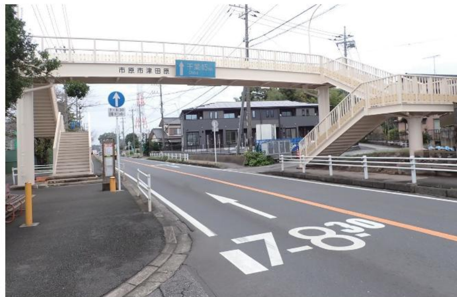
道路メンテナンス(道路付属物)工事 (湿津小前歩道橋補修工)
