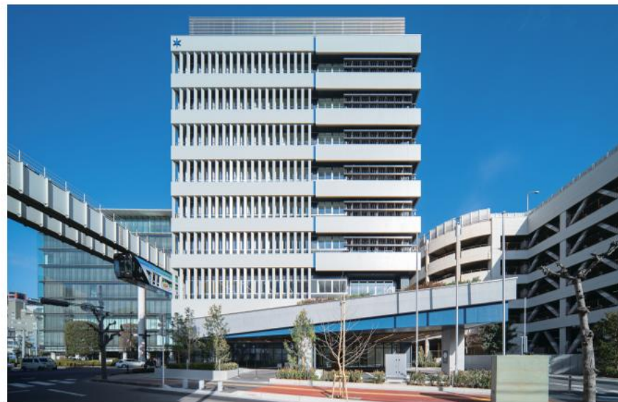
千葉県企業局本局新庁舎(仮称)電気設備工事
