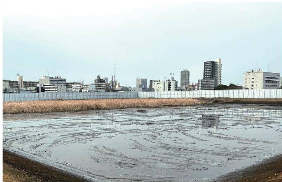
広域河川改修及び県単河川改良合併工事 (海老川調節池掘削工その2)
