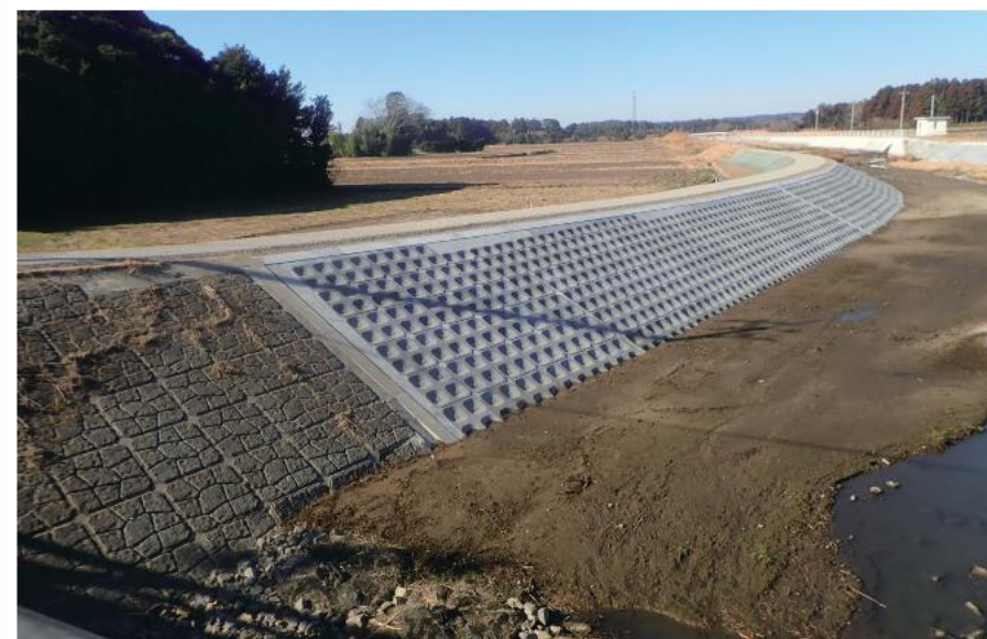
広域河川改修(大規模)工事 (赤目川護岸工その11)
