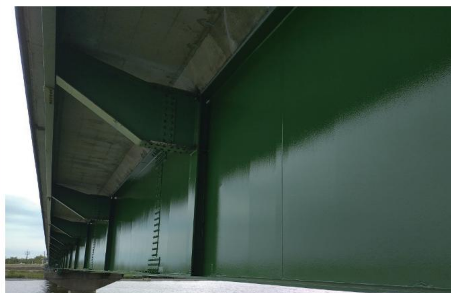
道路メンテナンス(橋梁)工事 (小見川大橋塗装工その1)
