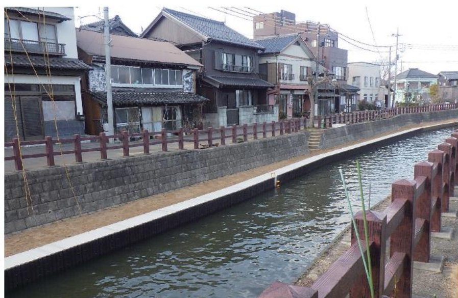
総合流域防災工事 (小野川鋼矢板護岸工)
