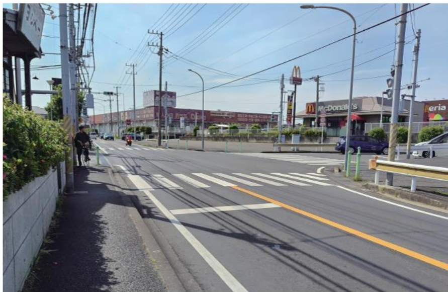
県単舗装道路修繕工事(大和田新田舗装工)
