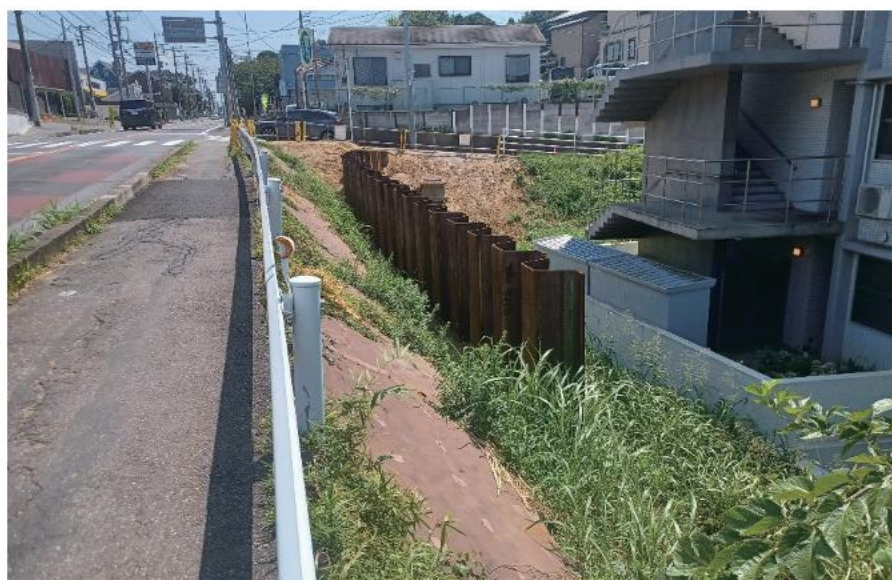
通学路緊急対策工事(実歩道整備工その2)
