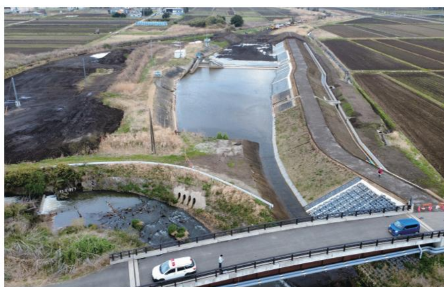
広域河川改修工事 (板附・作田川築堤工)
