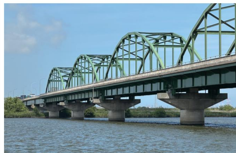
道路メンテナンス(橋梁)工事 (小見川大橋塗装工その2)
