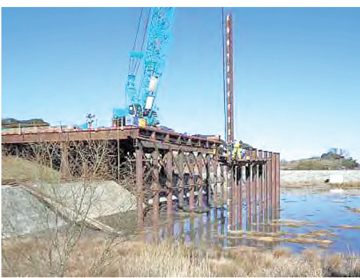
工事用道路(仮橋)施工状況
