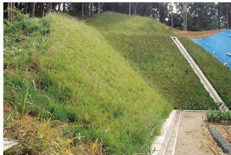
急傾斜地崩壊対策工事(一坪田1)・(株)小高興業
