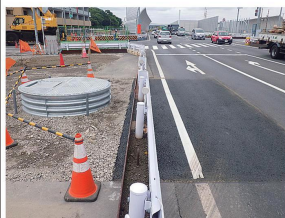
通水対策 完成
